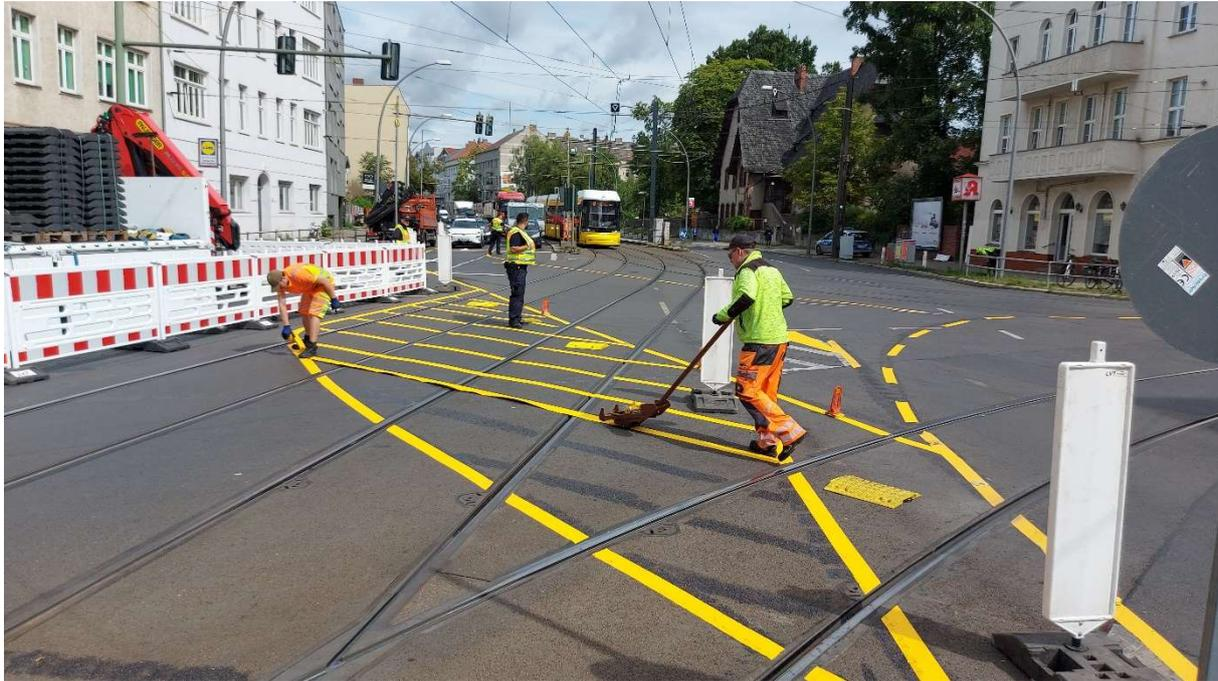
**Bild 3: Herstellung der Sperrfläche in der Kreuzung Berliner Allee / Buschallee**
